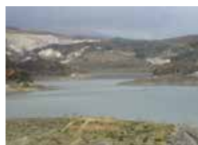
写真：荒砥沢ダム
