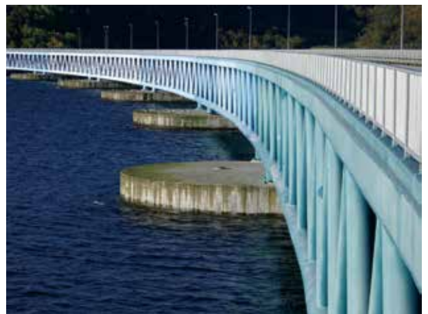
E39の浮橋ポンツーンとトラス構造
