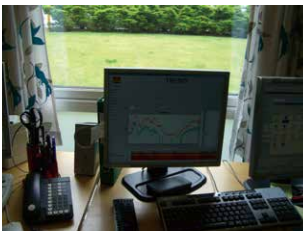
ガス濃度監視グラフ（中央監視室にて）
