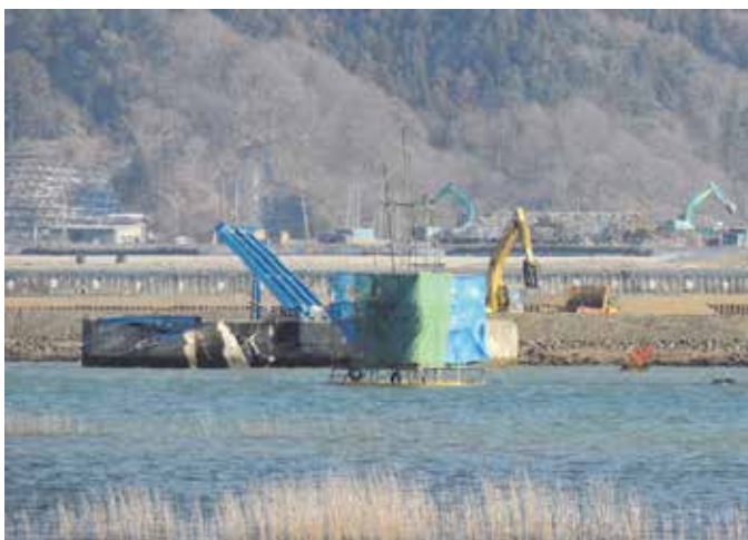
写真4. 水上でのボーリング調査の様子
