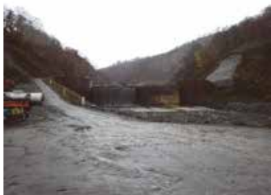
湯浜地区：砂防ダム（施工状況）
