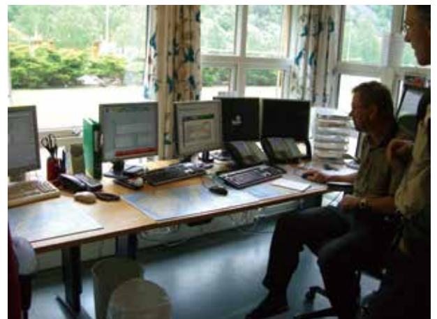
ラウダールトンネル中央監視盤
