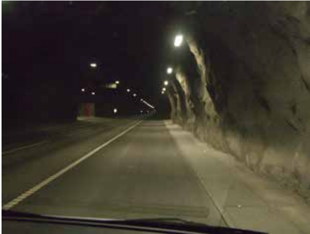
ラウダールトンネルの坑内（一般部）
