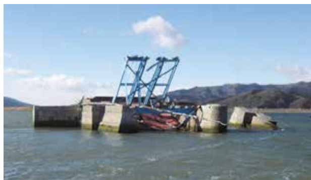
写真3. 釜谷水門の被災状況
