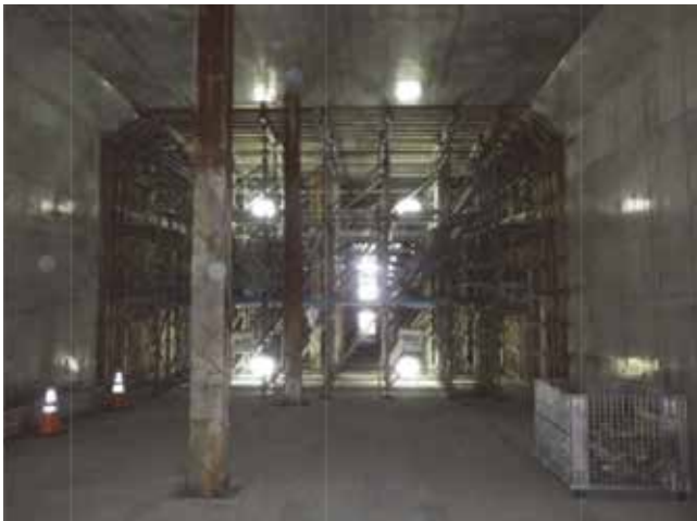
写真-1 函渠内部の施工状況
