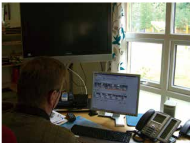
監視カメラ画像（中央監視室にて）
