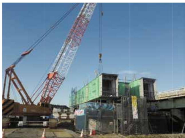
写真-4 クレーンベントによる架設状況
