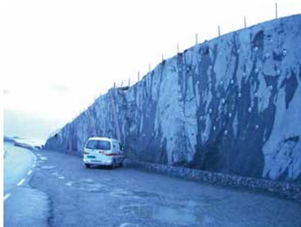
直切り岩盤斜面とその補強（ロックボルト）
