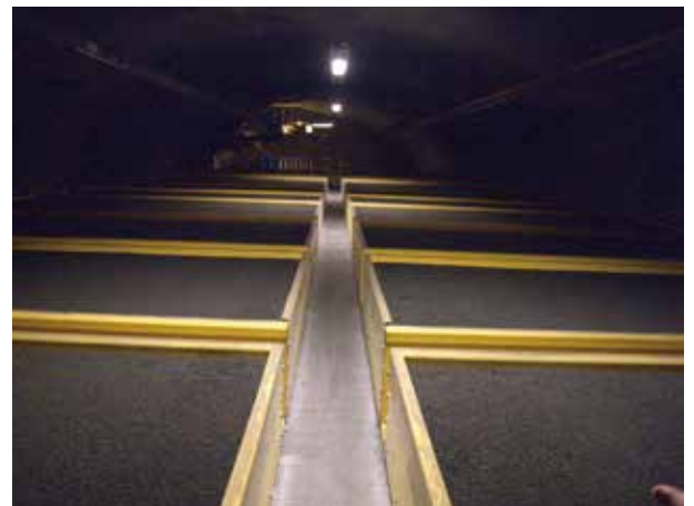
ラウダールトンネルの脱硝施設（吸着方式）
