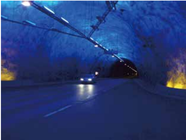
反転のための坑内拡幅部
