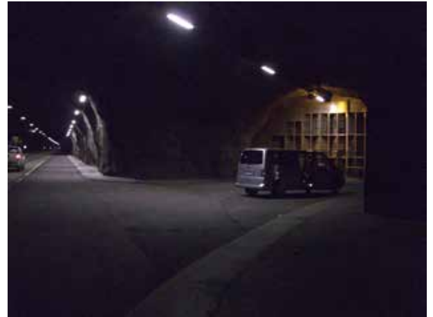
排ガス脱硝設備坑の入り口
