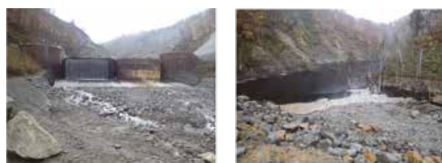
写真：湯浜砂防堰堤（右側は河道閉塞箇所）
