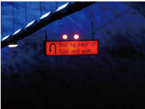
反転ポイントで反転指示を点灯したところ
