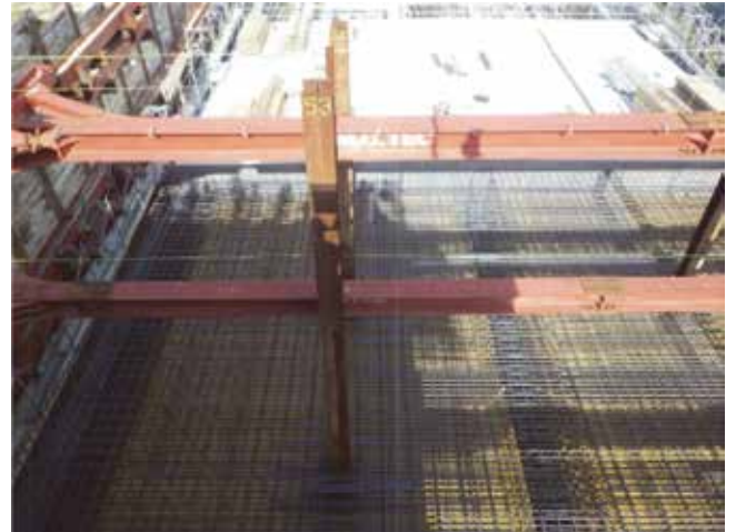
写真-2 函渠頂版の配筋状況
