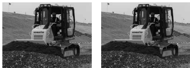
GNSSを用いた締固め管理（振動ローラ）とMCブルドーザー
