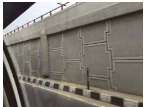
排水管に模様をつけたコンクリートで覆った例
