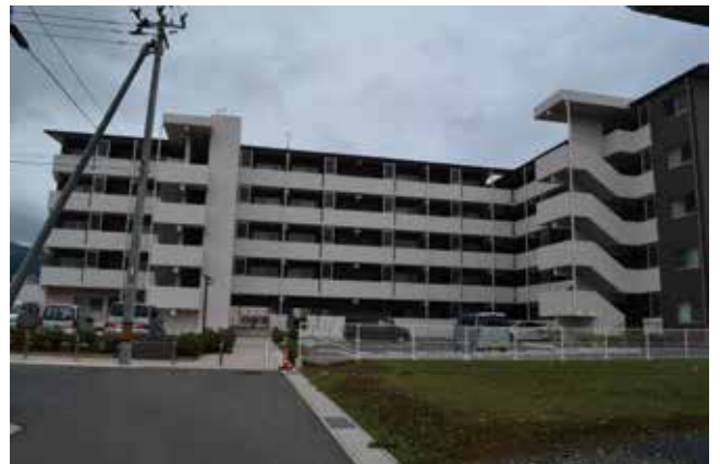
(新たに建設された駅周辺の災害公営住宅)
