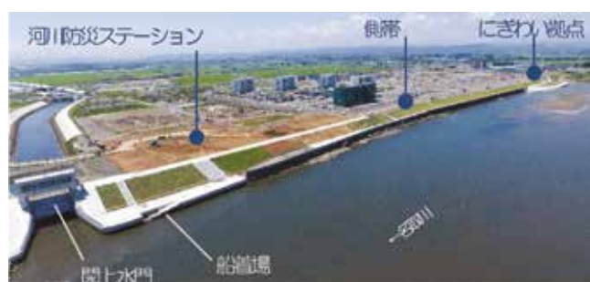
図-2 閑上地区周辺の復興工事状況（下流より望む）(H29.7.26施工状況)
