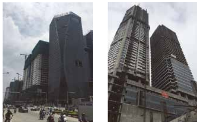
(ハノイ市内の建設現場)
