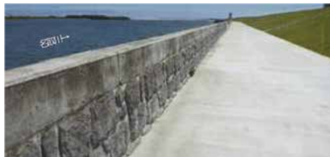
図-5 散策路施工状況 (既設特殊堤による転落防止柵)
