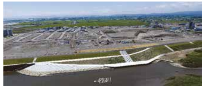
図-7 にぎわい拠点前テラス施工状況 (H29.8.2)
