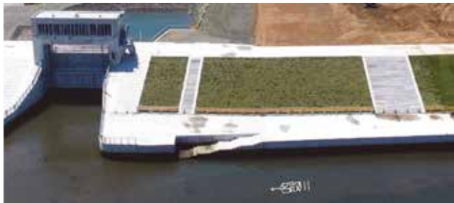
図-4 閑上水門上流船着場施工状況 (H29.8.2)
