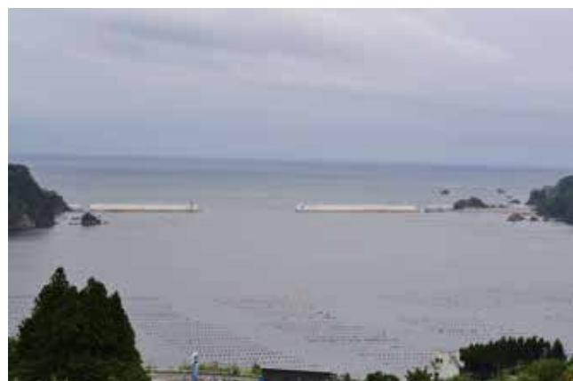
（新たに完成した大船渡湾防波堤）
