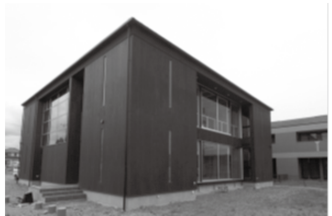
平成29年8月に完成した富岡本社
