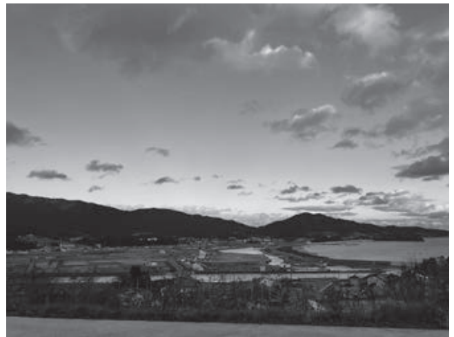
三陸沿岸道の復興状況（国内視察：陸前高田市）
