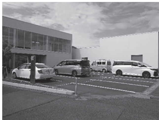
写真3：令和6年8月 現行社屋の東側に増築社屋建設中
