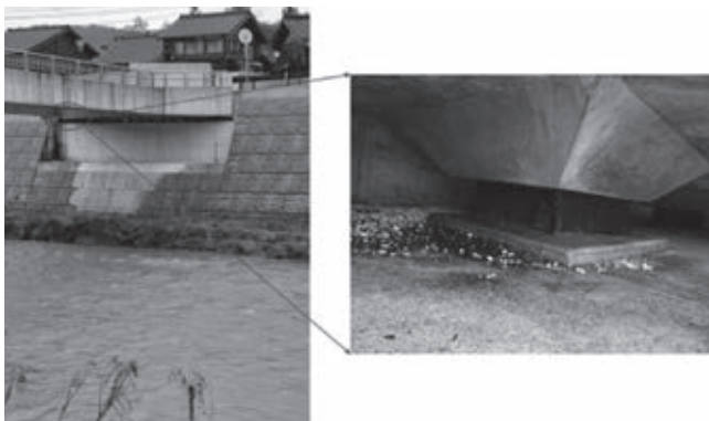
写真1：建設技術研究所（ポールカメラによる調査）
