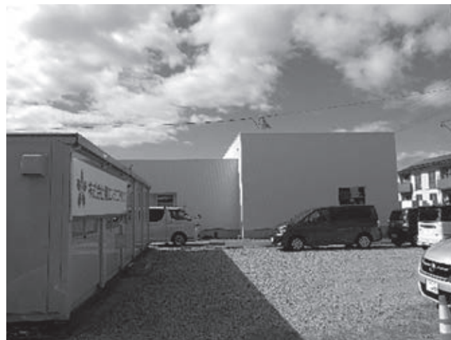
写真1：令和3年10月 プレハブ仮社屋の奥に社屋建設
