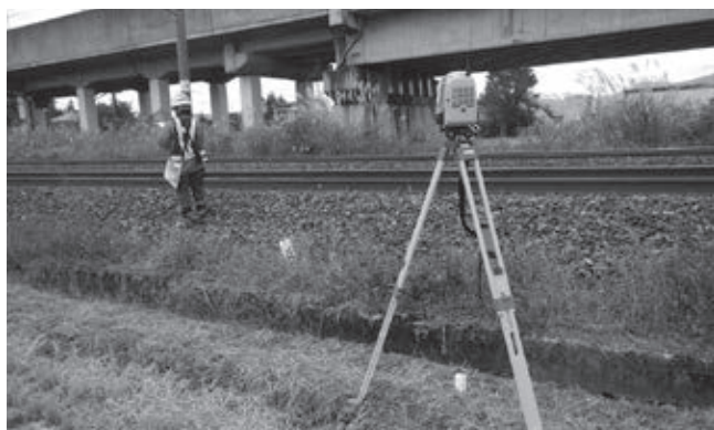
写真3 地上レーザ測量の作業状況
