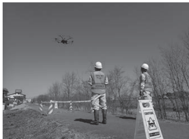
写真4 UAVレーザ測量の作業状況
