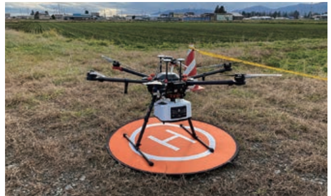
写真1 UAVグリーンレーザ測量の作業状況
