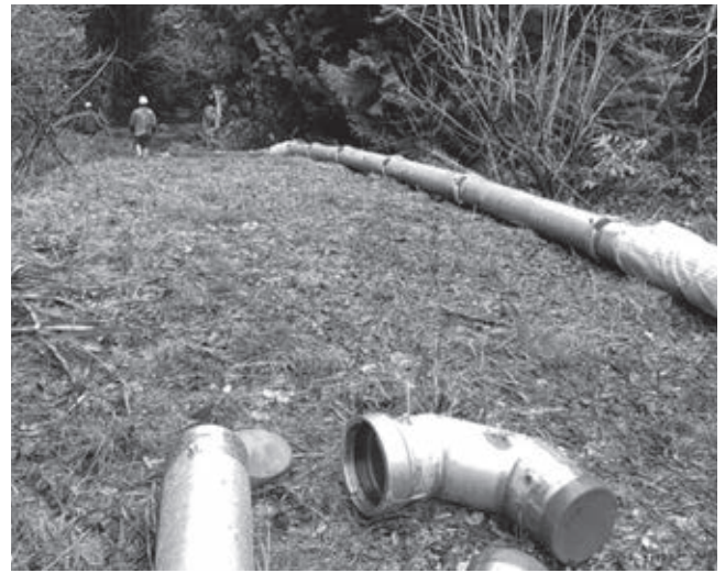
写真2：柿本商会（上下水道の応急処置）
