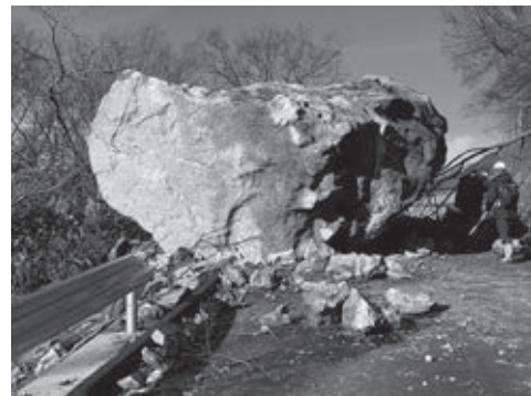
写真8：崩落した巨岩
