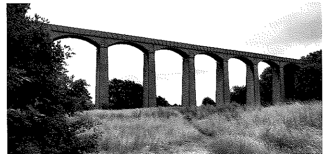
ポントカサステ水道橋
