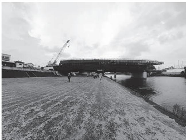
[写真：送出し工法による桁架設の様子]
