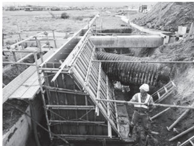
写真3 重力式擁壁の型枠組立の様子
