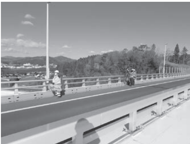
写-3：望遠カメラによる点検状況
