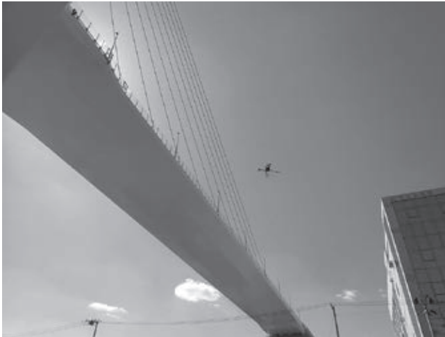
写-2：UAVによる点検状況
