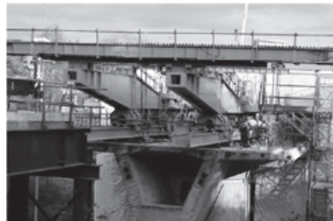
張り出し施工準備風景
