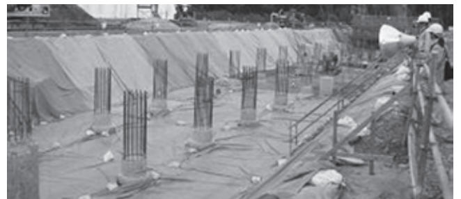
写真-2 場所打ち杭の施工
