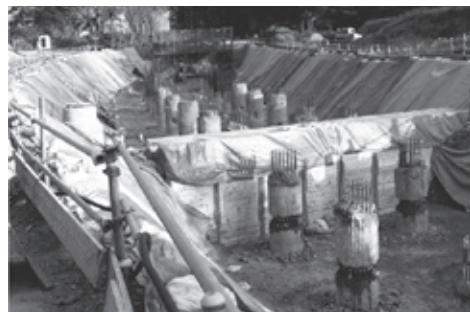
西公園高架橋杭打設後風景
