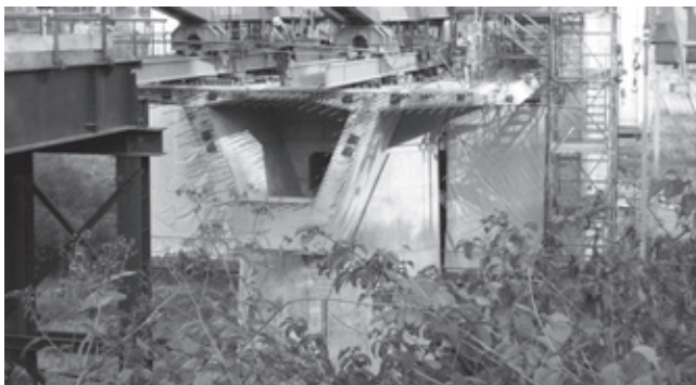
写真-1 P1橋脚
