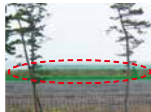
海岸堤防における植樹状況
