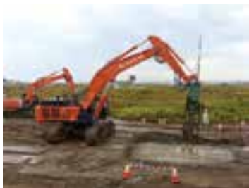
関上地区：施工状況（地盤改良）
