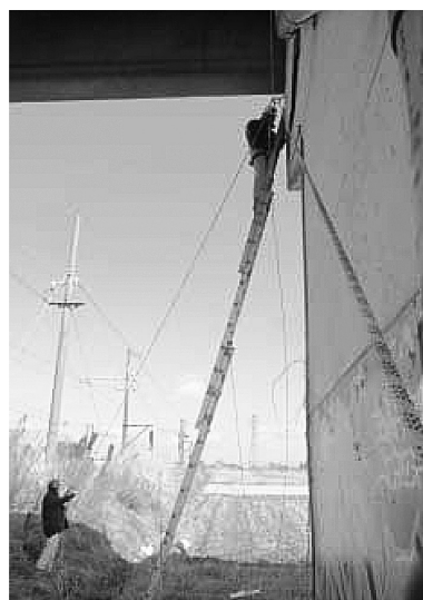
仙台岩沼線の玉崎橋を調査する技術者
