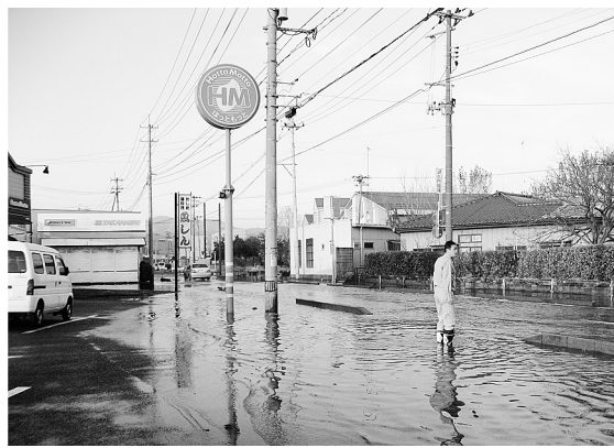
地盤沈下で1日2回（満潮時）浸水するため、道路下の流域幹線の被災調査が困難…宮城県石巻市
