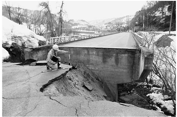
長野県北部地震で被害を受けた境川橋の橋台盛り土崩壊を調査中
