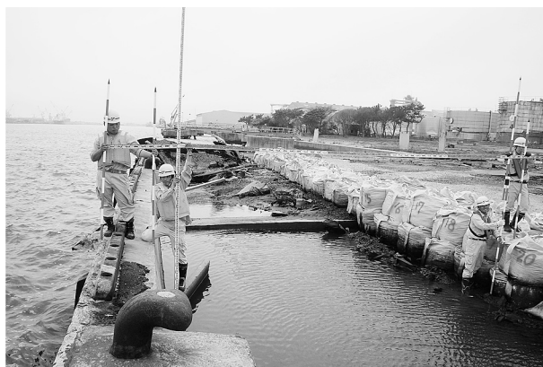
石巻港の被災現況調査
