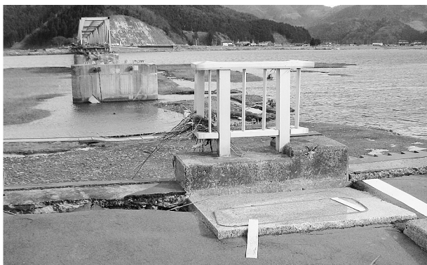
橋桁が流された新北上大橋
