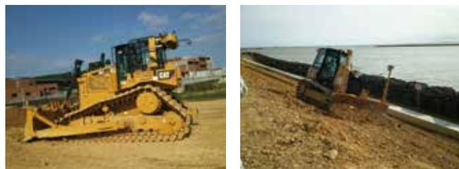
3Dマシンコントロール技術ブルドーザ 施工状況
