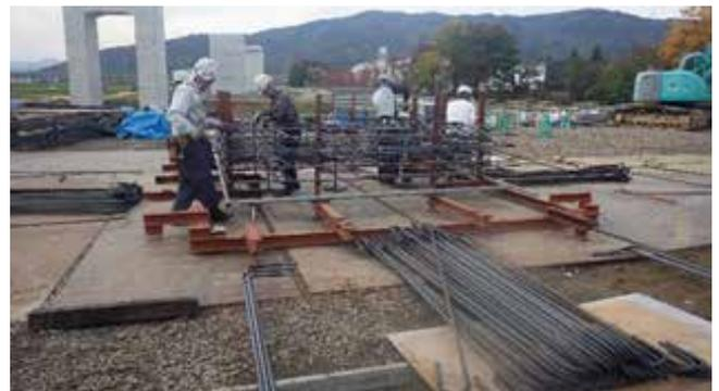
写真2 鉄筋組立作業の様子
