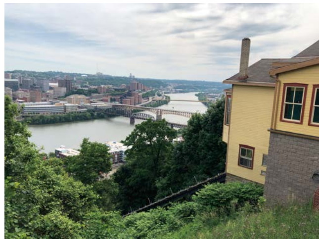
【インクライン展望台から市街地を撮影】 市街地は三角州に位置し、多くの橋梁が設置されている
