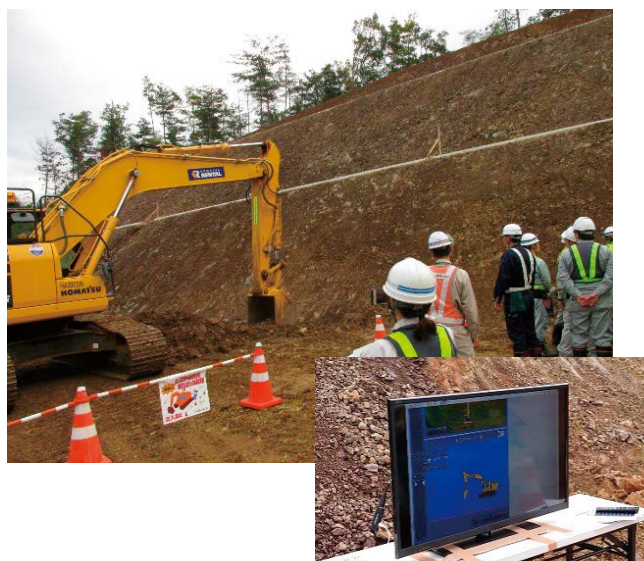
写真2 小平山地区道路改良工事 ICT建設機械デモ
