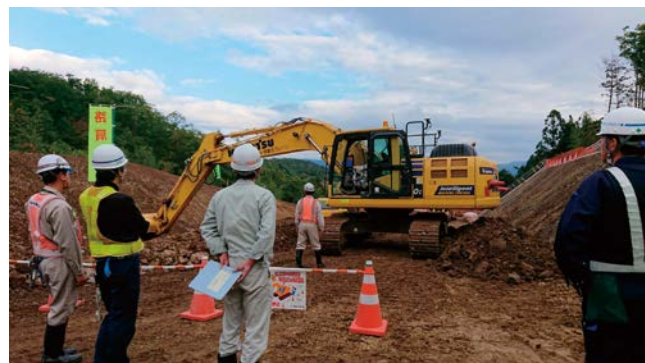
図-1 自動で施工面を認識するバックホウ
