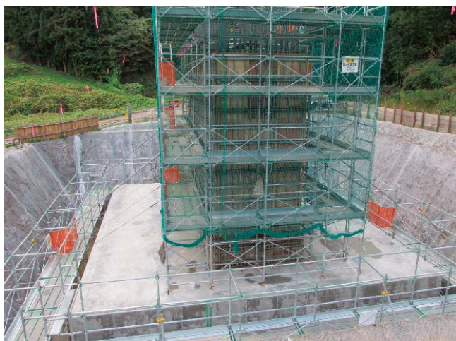
写真3 橋脚施工（桑折高架橋橋本地区下部工工事）
