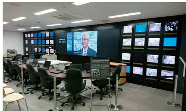
写真－8 東北地方整備局災害対策室（移築）
