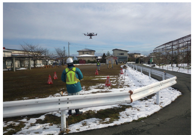
写真1 UAV作業の様子（離陸時）
