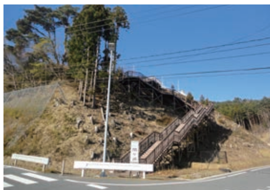
写真-3 漁港から高台移転地までの避難路（歩道橋）
