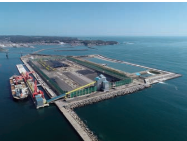
写真-4 小名浜港東港地区 大水深岸壁や航路・泊地等の整備を推進 (福島県いわき市)
