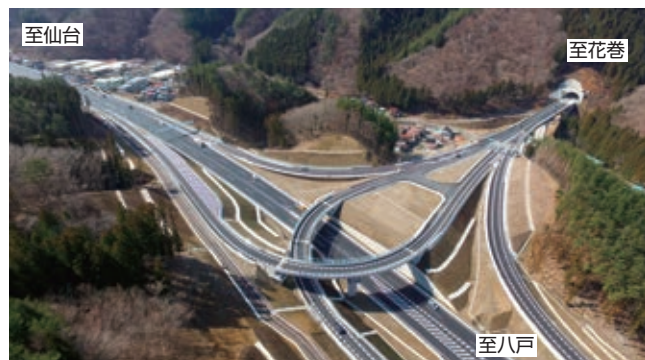
完成した釜石JCT
