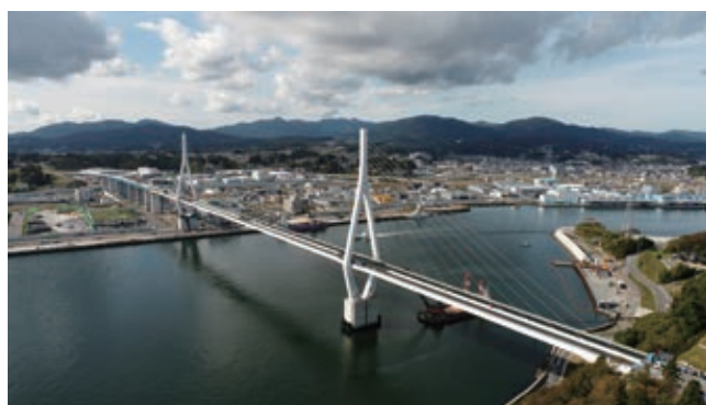
写真-2 気仙沼湾横断橋 復興のシンボルとなる長大橋で国内でも有数の斜張橋 (宮城県気仙沼市)
