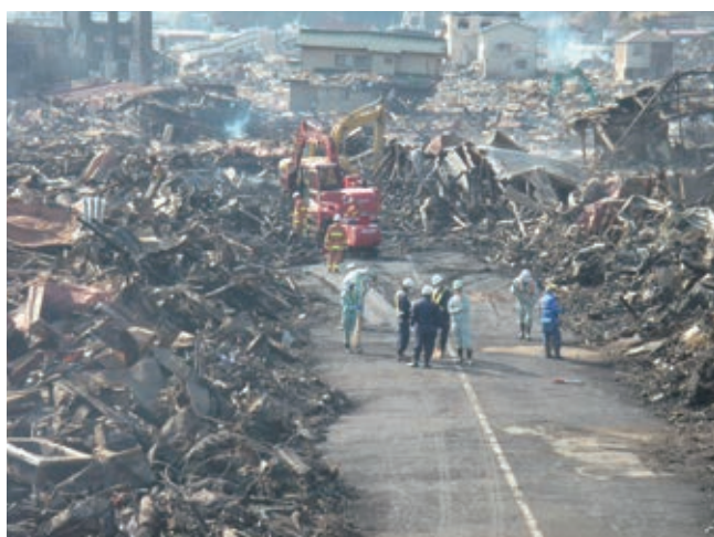
写真-1 道路啓開 とにかく車が通れるだけのルートを切り啓く (宮城県気仙沼市)
