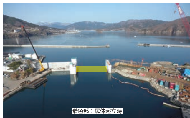
完成した細浦地区“起伏式フラップゲート水門”
