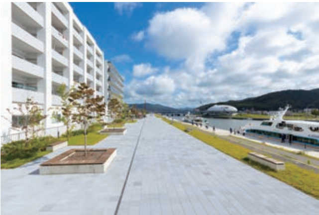
写真-3 旧北上川中央地区の堤防整備 まちづくり計画と連携した整備 (宮城県石巻市)
