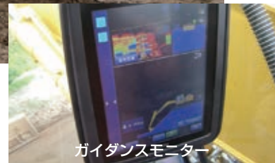
ICT建機による施工状況
