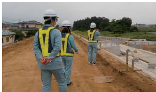
〔施工中現場の見学〕
