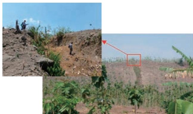
写真2.2 米国コンサルタントが掘削した調査トレンチ
