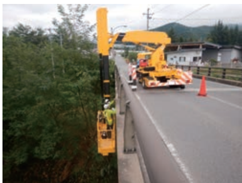
橋梁点検車による点検作業
