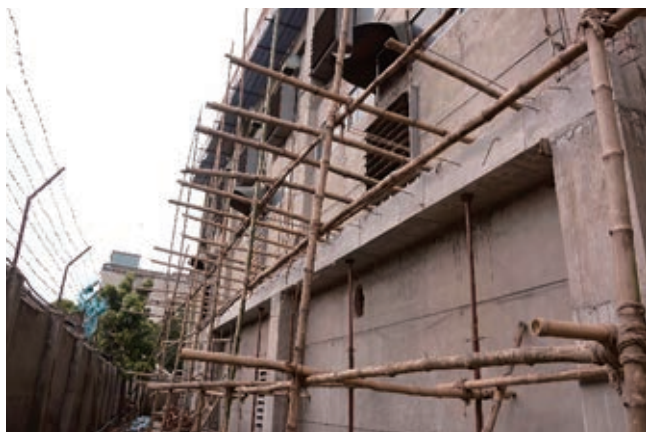
図2 竹足場の設置
