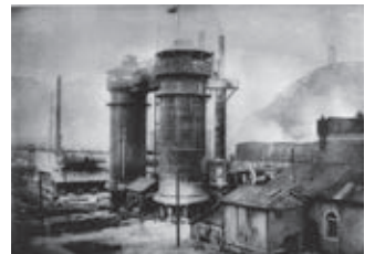
改修された高炉
