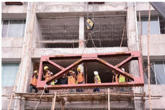
図3 クレーンによる鉄骨プレースの設置
