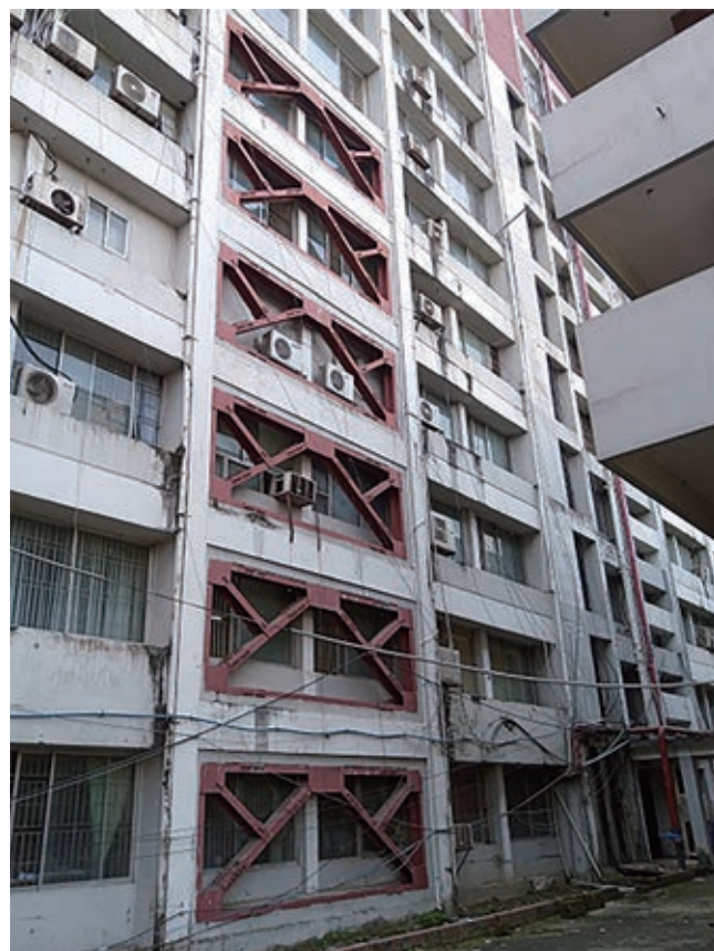
図4 PWDのプロジェクトによる耐震補強
