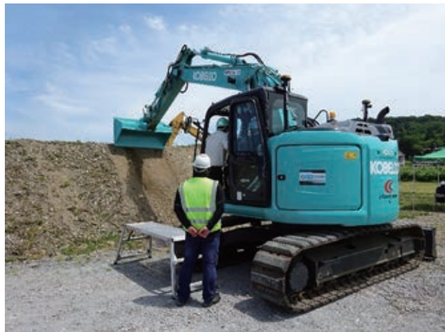
ICT 施工講習会
