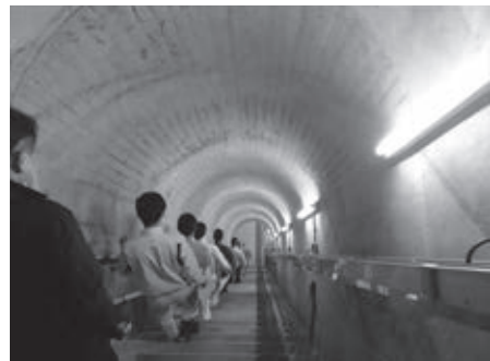
写真2 最上小国川ダム監査廊
