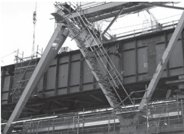
写真1-1 架設桁組立状況
