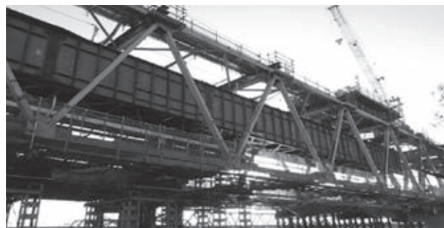
写真1 高水敷内にて架設桁を組み立てている様子
