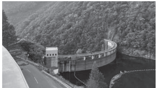
写真2 鳴子ダムの全景
