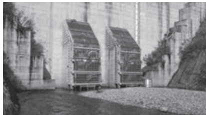
写真1 最上小国川ダム上流側
