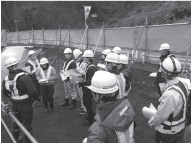
写真2 現場見学の様子
