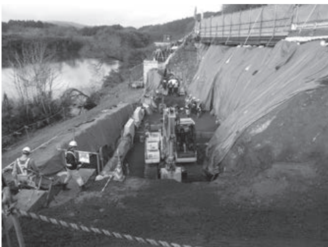
写真1 補強土壁の施工現場
