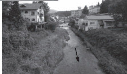
写真4 最上小国川ダム下流の赤倉地区
